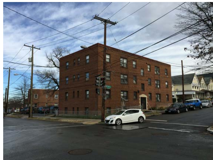
2. 1000 OTIS ST NE
